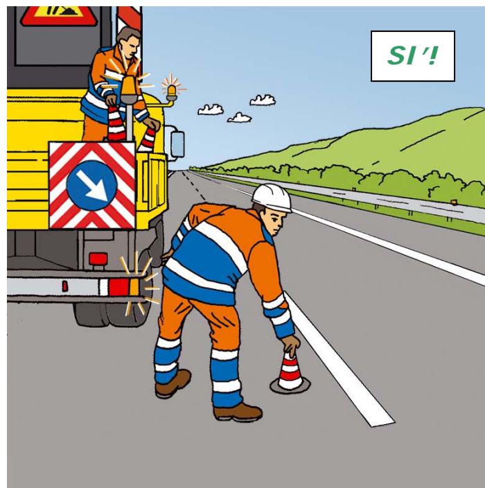
Figura 59 – Posizionamento dei coni o defleco: comportamento corretto
